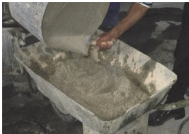
Slika 1. Priprema tradicionalnog Horasan morta
